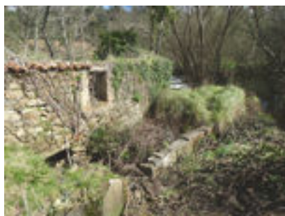
Ruínas dun dos dous antigos muíños da ponte do Baiúso (Lamas), quizais construídos no séc. XVII (foto XMLS)
