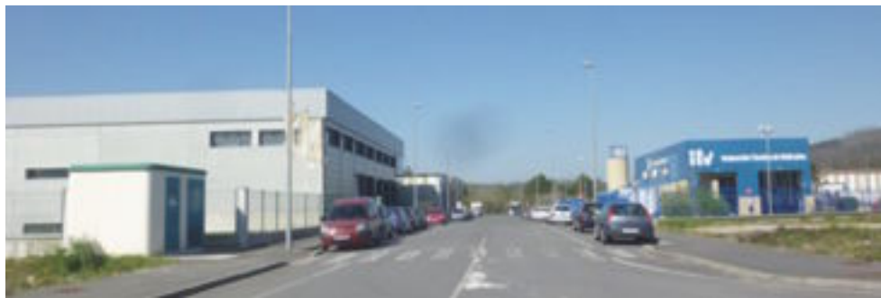
Instalacións da ITV e outras naves no polígono industrial (Foto EDR)
