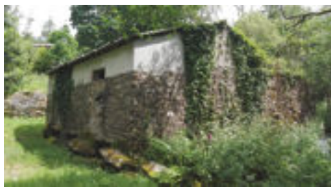
Edificio principal dos Muíños do Allo (foto EDR)
