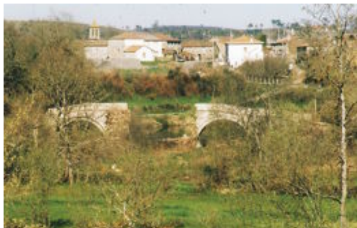
Vista de Brandomil en 1989, despois de que as grandes inundacións destruísen o arco central (foto Xosé M a Lema)
