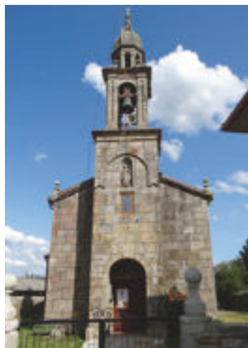
Fachada da igrexa de San Martiño de Meanos, obra de Ignacio García, mestre de obras de Mira (foto XMLS)
