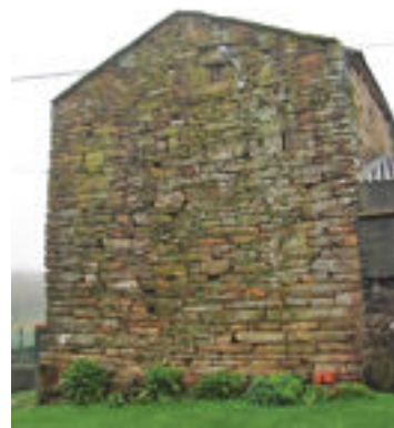
Paredes sur dos restos da Torre do Couto (Foto XMLS)
