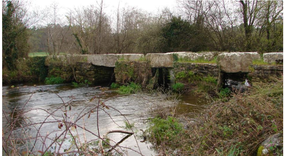
A ponte de pedra (ou Ponte Vella) de Vilar, lugar de paso desde épocas remotas [Foto XMLS]
