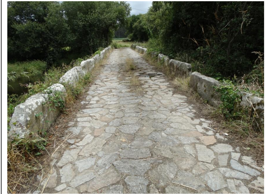
Chan refeito e pentorís da Ponte Vella de Vilar [Foto XMLS]
