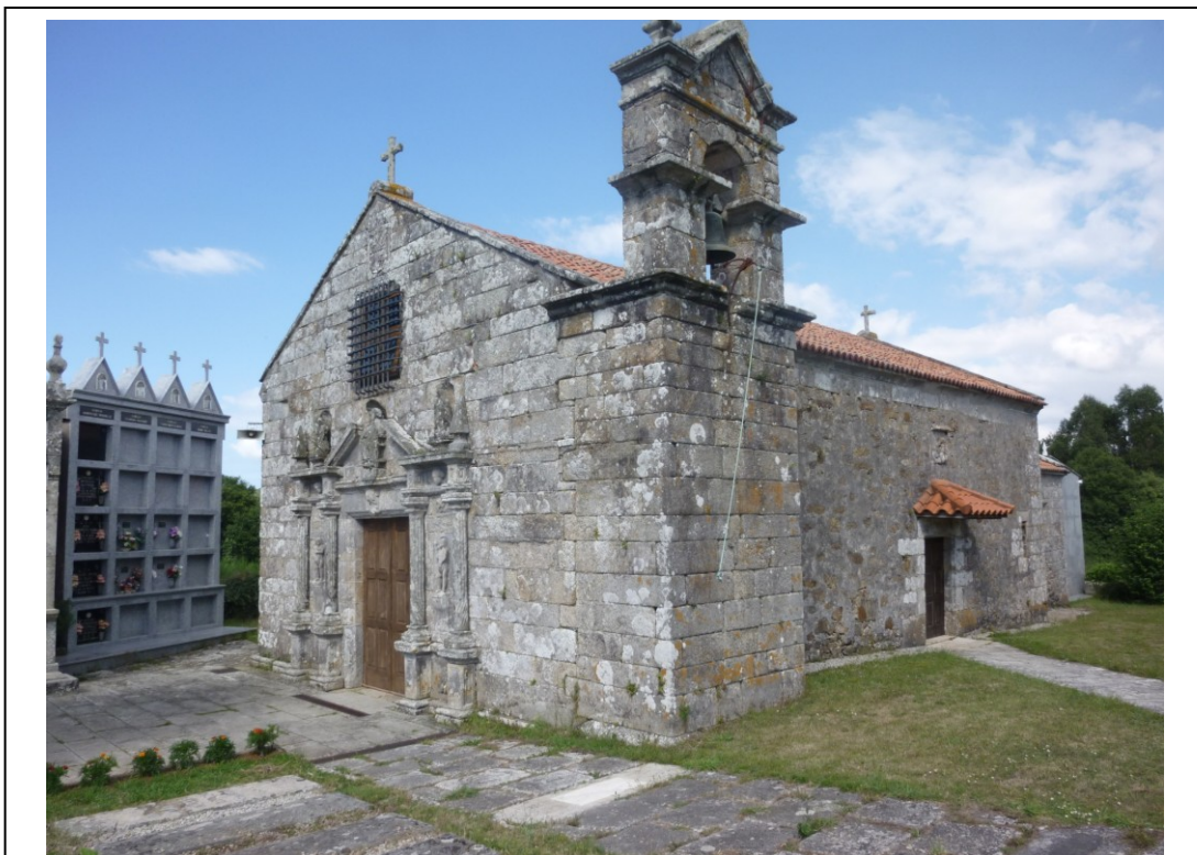
Igrexa de San Pedro do Allo, construída na súa maior parte entre 1561 e 1607 (foto EDR)
