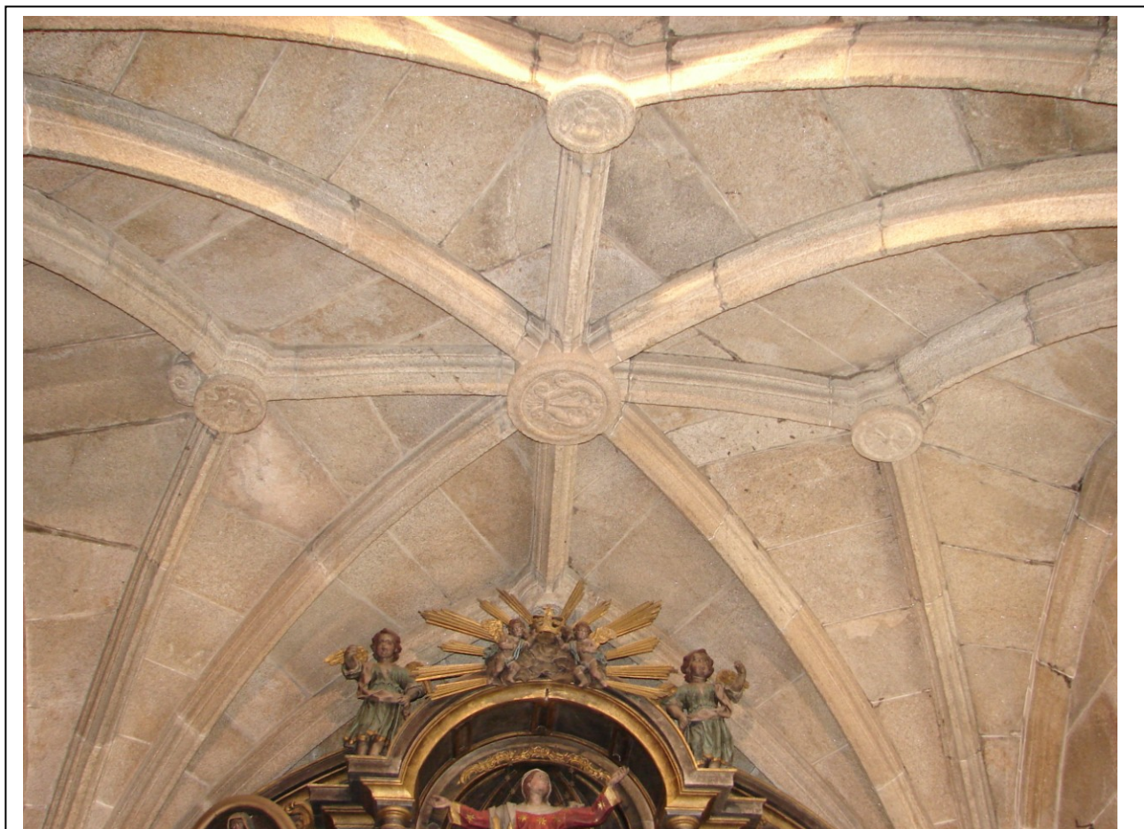
Bóveda estrelada gótica da capela maior da igrexa de Lamas (foto XMLS)
