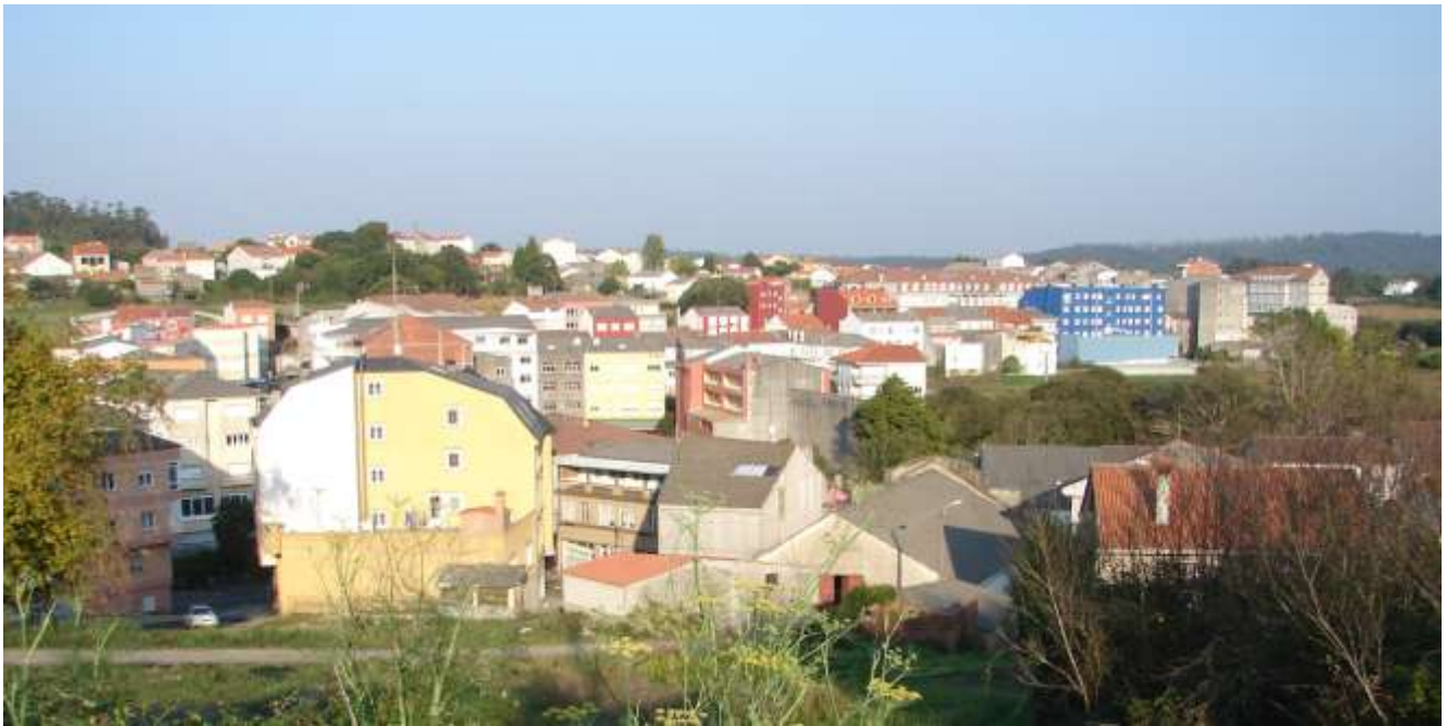
Vista parcial de Baio, con edificios da Piroga en primeiro plano (foto XMLS)
