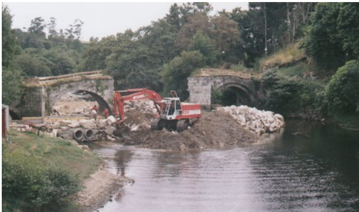
Obras de restauración da Ponte Vella (1993) [foto XMLS]
