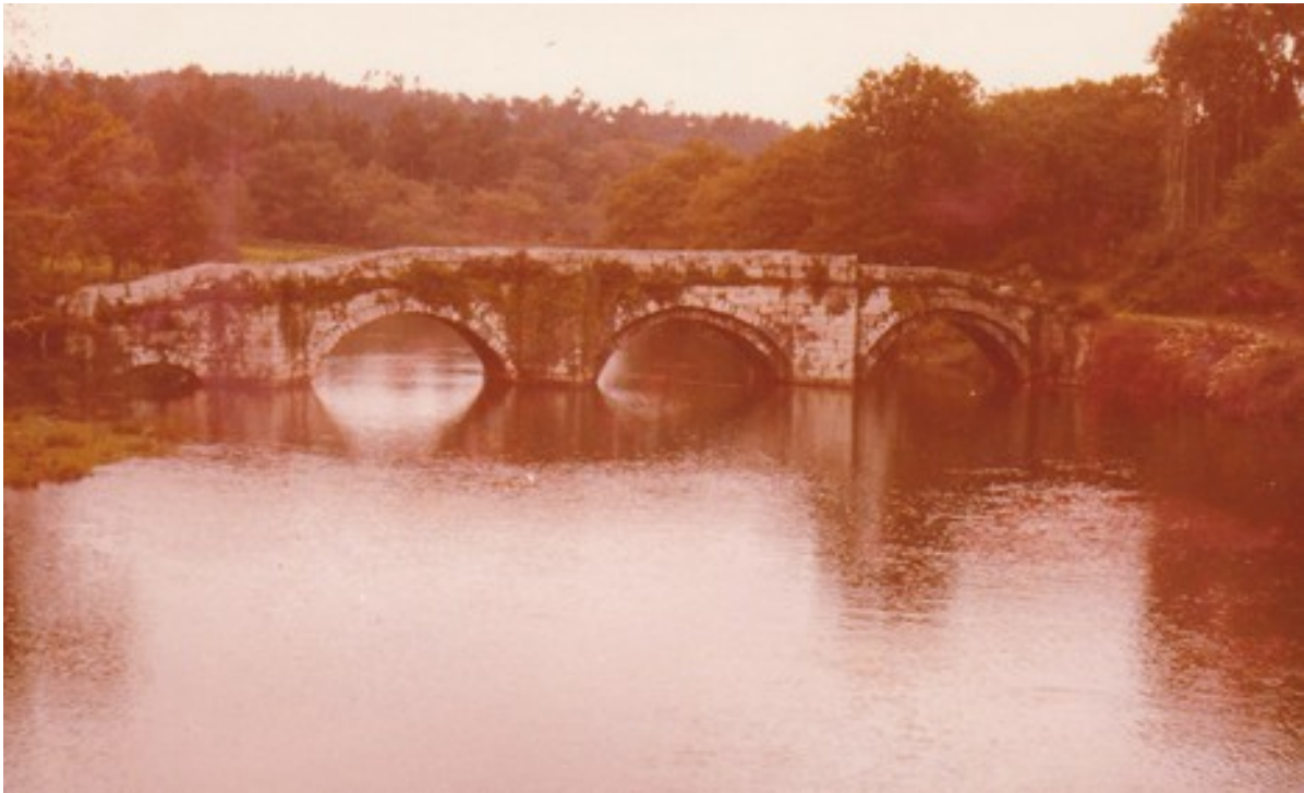
A Ponte Vella de Brandomil nos anos '70 (foto Ramiro Rodríguez)
