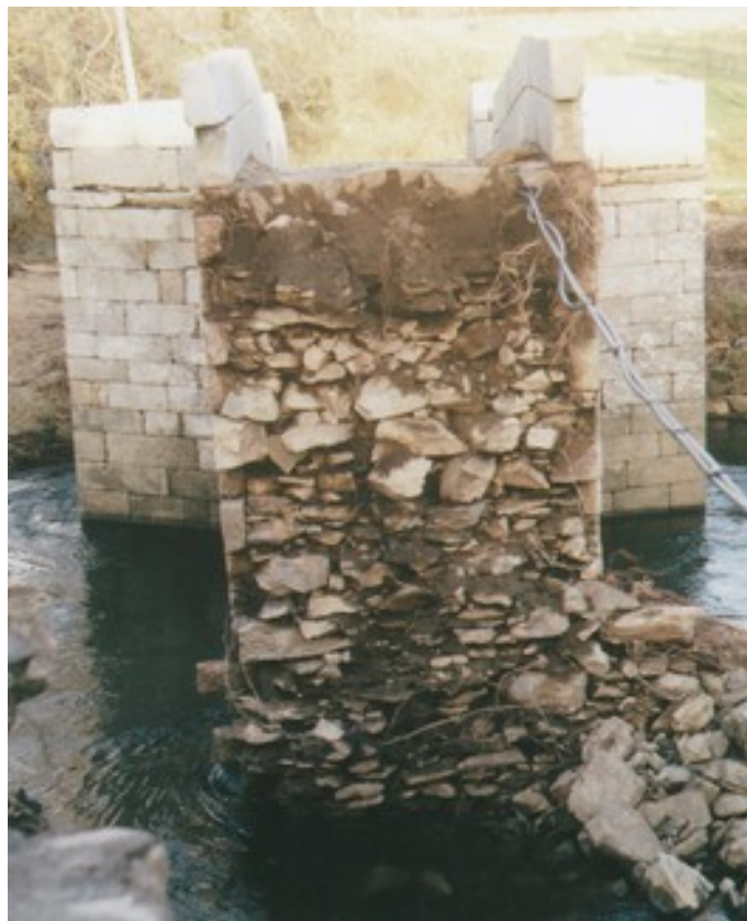
O aparello dun dos machóns centrais da Ponte Vella ó descuberto, despois das inundacións (1989) [foto XMLS]
