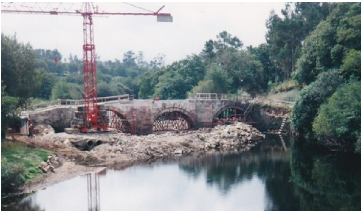
A Ponte Vella no remate da restauración (1994) [foto EDR]
